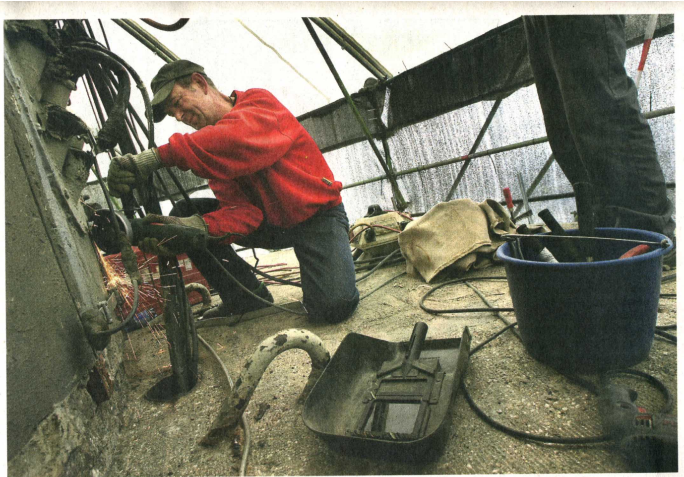
Arbeiter sind derzeit in gut 160 Metern Höhe mit der Instandsetzung der Betonplatte beschäftigt. Der defekte äußere Rand wurde um etwa einen halben Meter abgetragen. In vier Wochen soll die Sanierung abgeschlossen sein.
